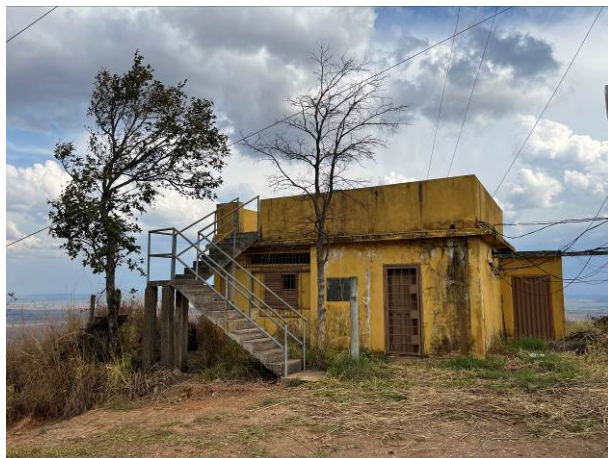
Foto 07: Construção da empresa de telecomunicação presente no topo do morro.
