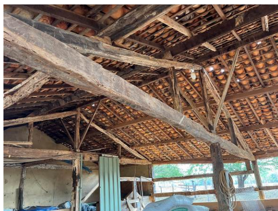
Foto 08: Vista interna do curral. Destaque para a grande dimensão da peça de madeira inteiriça que conforma a linha da tesoura, indicativo de uma antiga época de construção.
