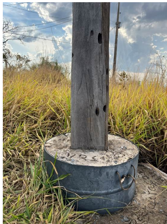
Foto 04: O reforço em base de concreto do Cruzeiro, após diversas substituições anteriores.
