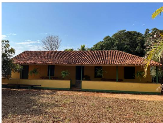
Foto 01: Vista frontal da casa sede da fazenda.
