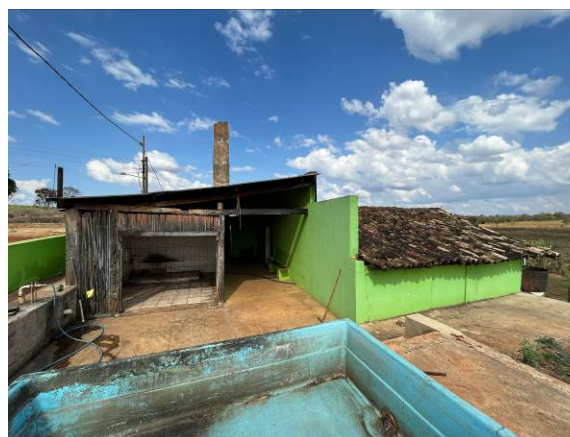
Foto 08: Vista externa da construção que abriga o alambique.
