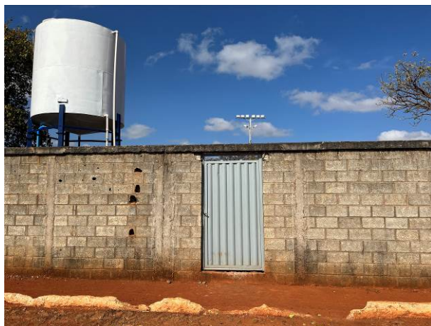
Foto 07: Vista da entrada do campo mais utilizada. Destaque para sua falta de pavimentação.
