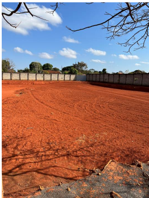
Foto 05: Local da futura quadra de areia, já sendo aterrado.
