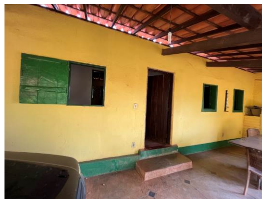
Foto 02: Vista da fachada posterior do imóvel.
