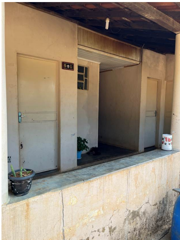
Foto 05: Vista do interior do imóvel a partir da fachada frontal.
