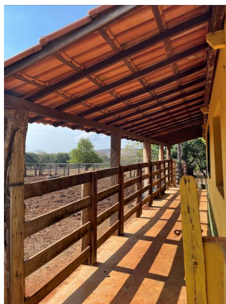
Foto 04: Vista da fachada lateral direita, que recebeu uma nova cobertura em telhado cerâmico.
