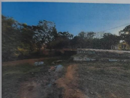
Foto 01: Vista geral da ponte e do entorno.
