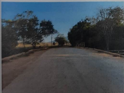
Foto 03: Vista da chegada sobre a ponte a partir da área urbana de Morro da Garça.
