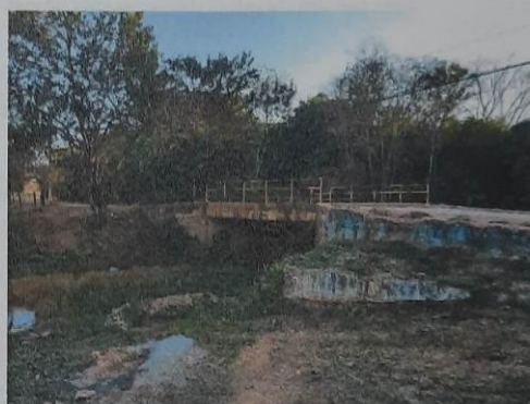
Foto 02: Vista aproximada da estrutura em concreto.
