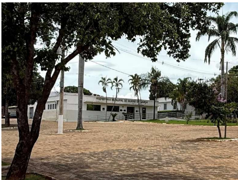
Foto 17 (04/11/2025) Prefeitura Municipal de Morro da Garça apresentando bom estado de conservação. Autoria: Racchel Santiago
