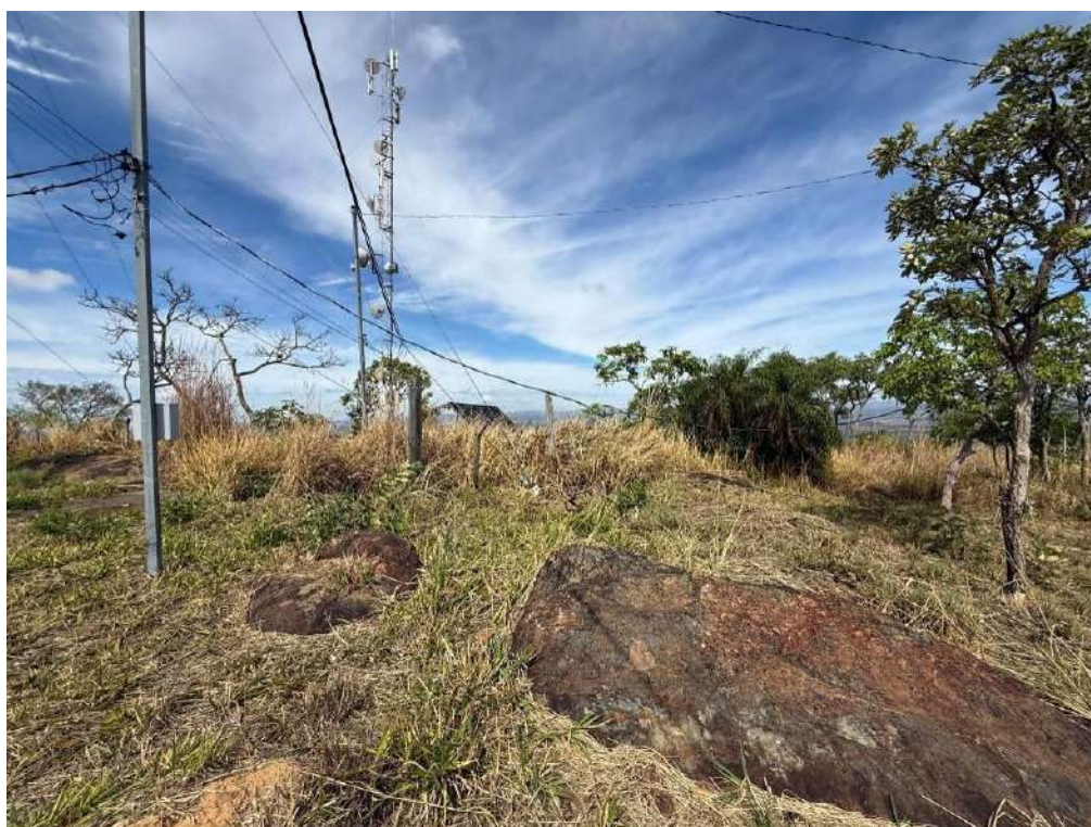
Foto 23 (04/11/2025) Trecho das instalações existentes no cume do Morrão. Autoria: Racchel Santiago
