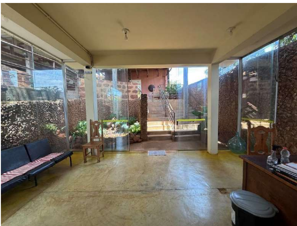
Foto 04 (04/11/2025) Estrutura em concreto armado do anexo, sem danos. Autoria: Racchel Santiago
