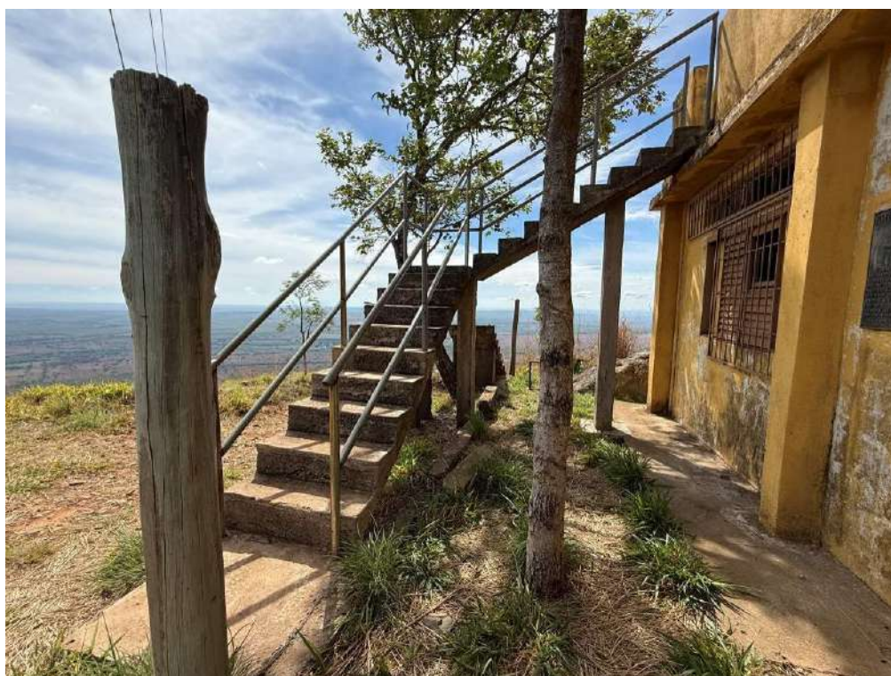
Foto 11 (04/11/2025) Escada de acesso ao terraço da edificação técnica. Autoria: Racchel Santiago
