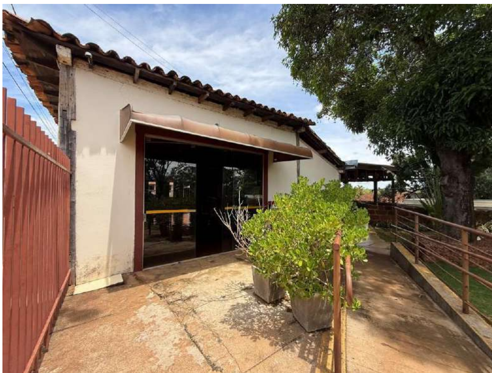
Foto 18 (04/11/2025) Piso cimentado, localizado no quintal, apresentando danos superficiais. Autoria: Racchel Santiago
