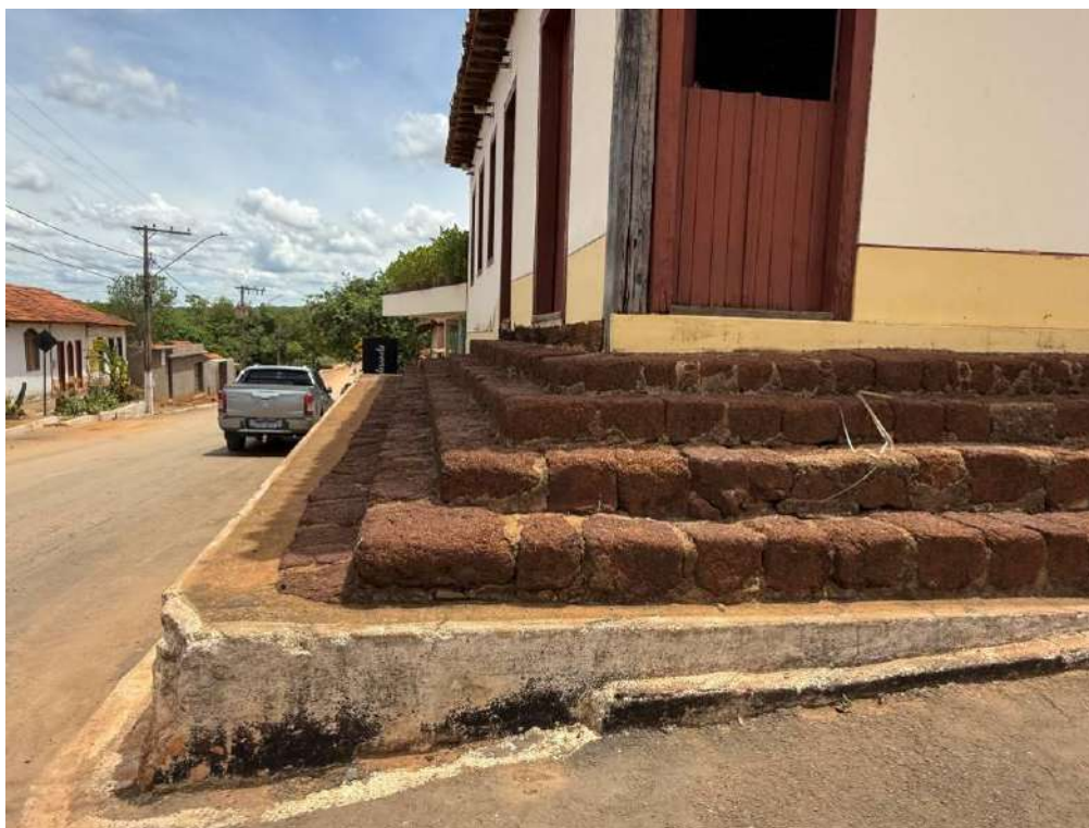
Foto 17 (04/11/2025) Vista da escada executada em pedras do tipo canga. Autoria: Racchel Santiago
