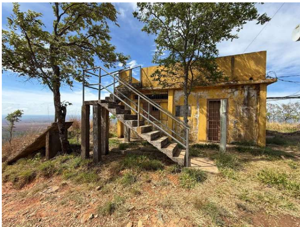
Foto 10 (04/11/2025) Fachada frontal da edificação técnica. Autoria: Racchel Santiago
