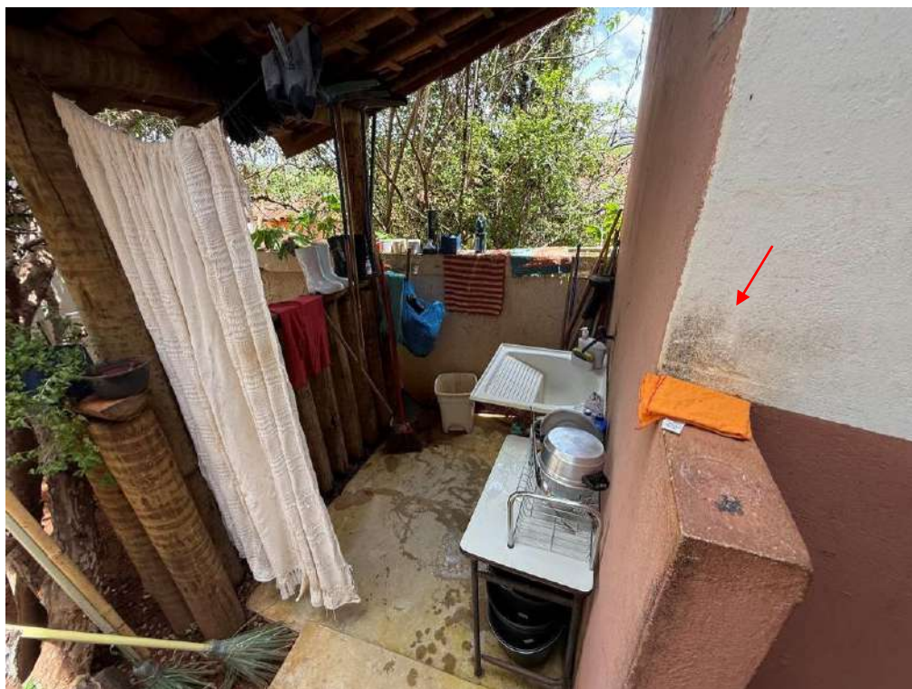
Foto 11 (04/11/2025) Trecho da camada pictórica apresentando sujidades aderidas. Autoria: Racchel Santiago
