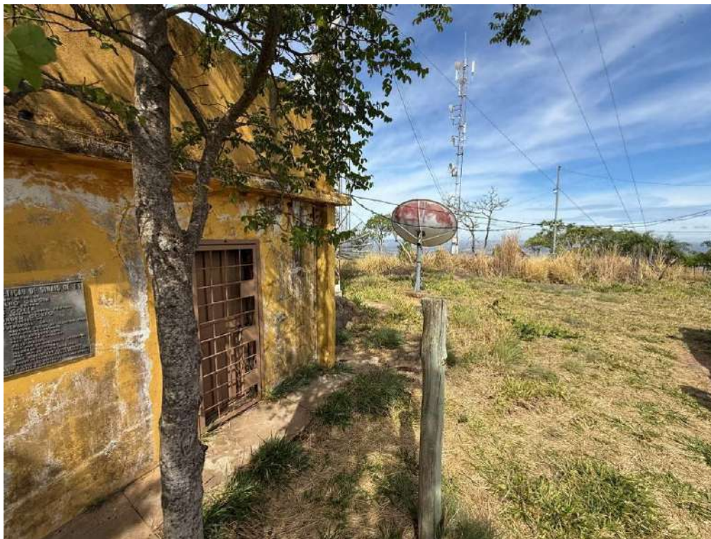
Foto 18 (04/11/2025) Implantação das antenas e fiação elétrica aérea entre elas. Autoria: Racchel Santiago
