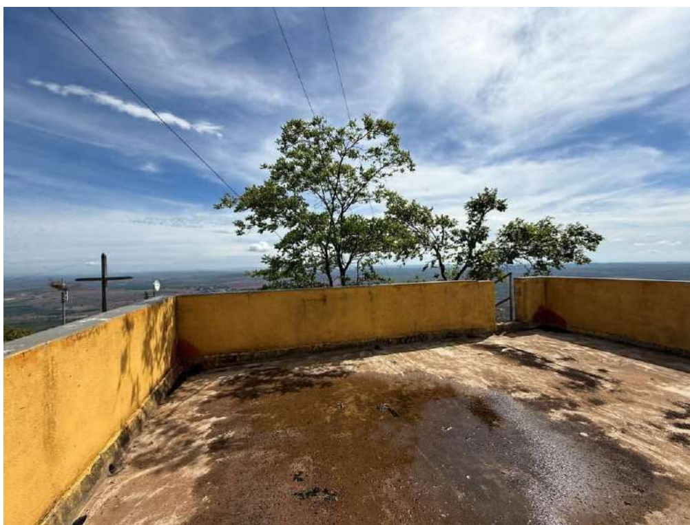
Foto 13 (04/11/2025) Vista do terraço da edificação técnica. Autoria: Racchel Santiago
