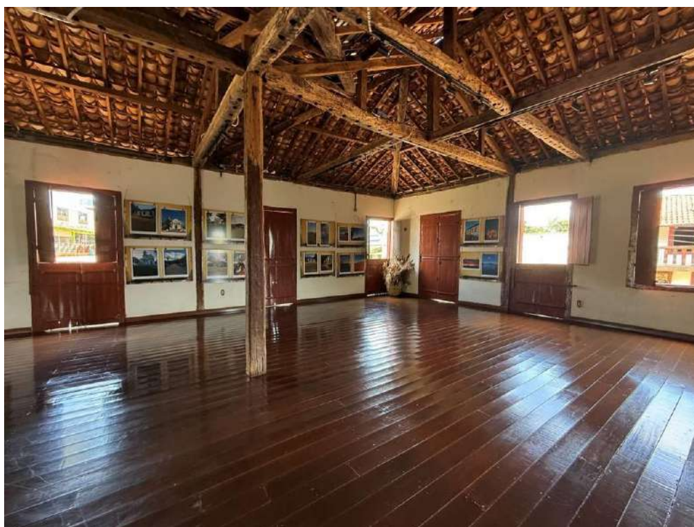
Foto 20 (04/11/2025) Vista geral do piso em tabuado de madeira, apresentando bom estado de conservação. Autoria: Racchel Santiago
