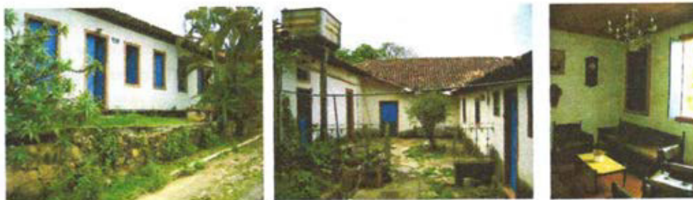
Vistas Gerais da Residência
