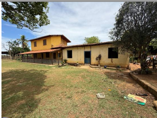
Foto 03: Vista da edificação adjacente à sede da fazenda.
