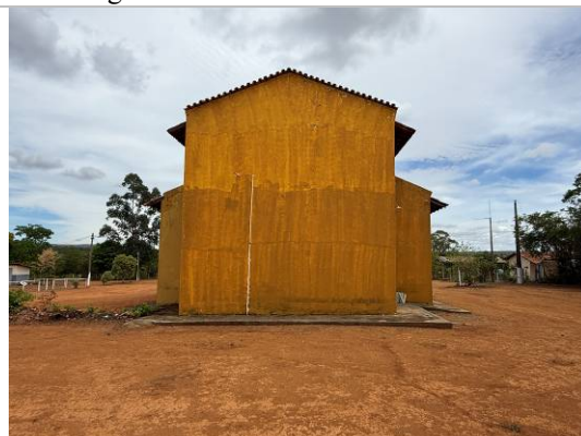
Foto 02: Fachada posterior da edificação. Autoria: Racchel Santiago Data: 04/11/2025
