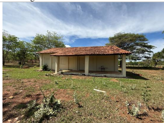
Foto 02: Fachada posterior do imóvel. Autoria: Racchel Santiago Data: 04/11/2025
