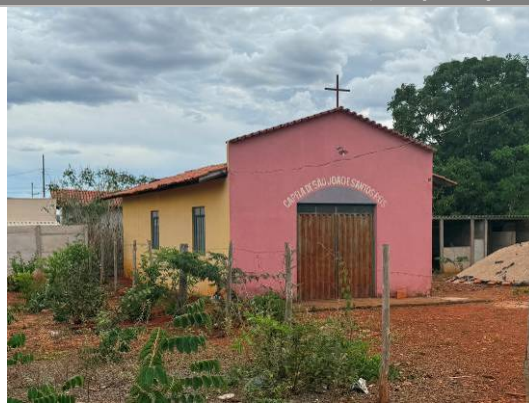
Foto 04: Vista em perspectiva da fachada lateral direita.
