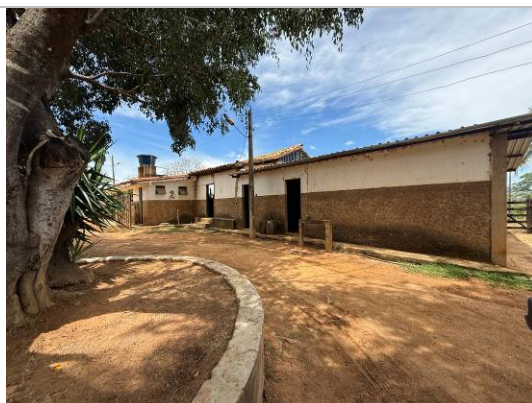
Foto 06: Vista de uma das edificações de apoio.
