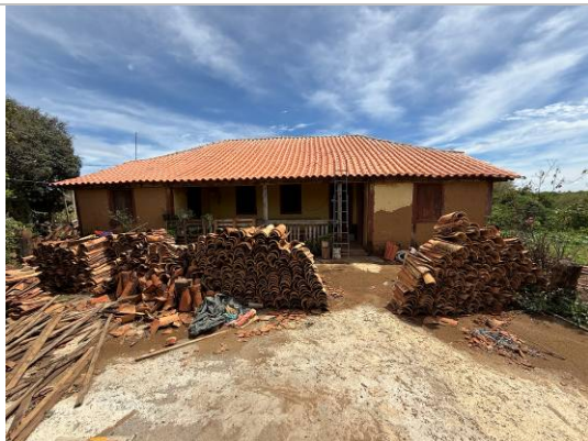
Foto 01: Fachada frontal da residência de Valter Fernandes de Souza. Autoria: Racchel Santiago Data: 04/11/2025
