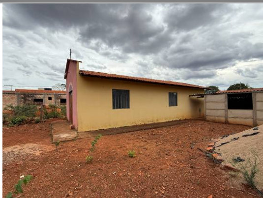
Foto 03: Vista da fachada lateral esquerda da edificação.
