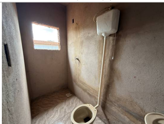
Foto 08: Banheiro da sacristia.
