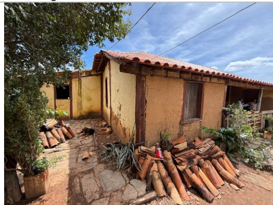
Foto 02: Vista em perspectiva da edificação. Autoria: Racchel Santiago Data: 04/11/2025
