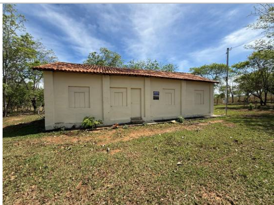
Foto 01: Fachada frontal da edificação. Autoria: Racchel Santiago Data: 04/11/2025
