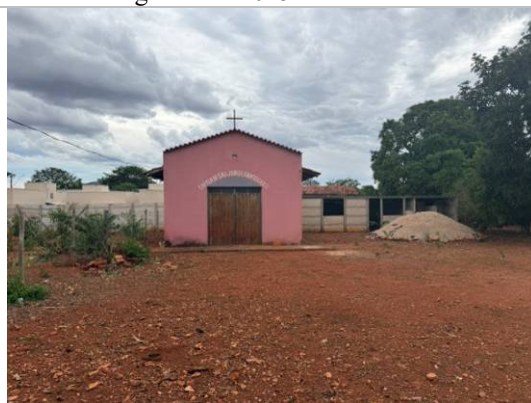
Foto 02: Fachada frontal da edificação. Autoria: Racchel Santiago Data: 04/11/2025
