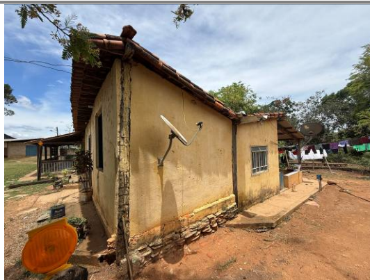
Foto 04: Vista em perspectiva da edificação adjacente à fazenda.
