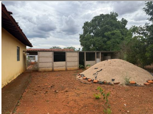
Foto 09: Edificação de apoio, em fase de construção.
