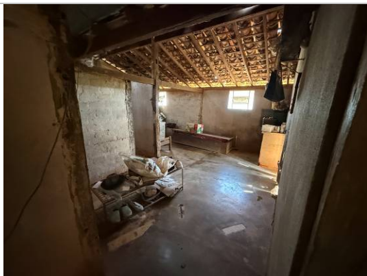
Foto 07: Vista de um dos ambientes internos do imóvel. Autoria: Racchel Santiago Data: 04/11/2025
